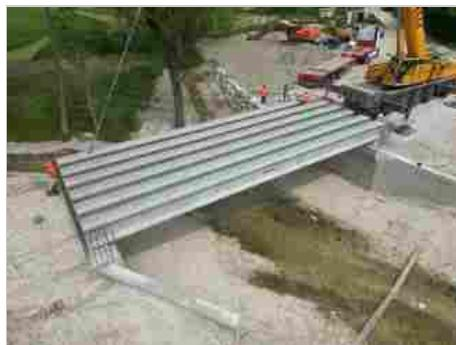
Sant'Abbondio, con il varo delle travi di metà maggio, il nuovo ponte carrabile in cemento armato precompresso è ormai una realtà. Mancano davvero pochissimi giorni per soletta, rampe e consegna del cantiere a cui seguirà, a stretto giro, anche quello di Serra de' Conti. Il ponte sul Cinisco, affluente del Cesano, è il primo degli undici ponti che la Regione Marche, tramite il sub-commissario per l'alluvione ing. Stefano Babini ha affidato al Consorzio di Bonifica delle Marche con un
