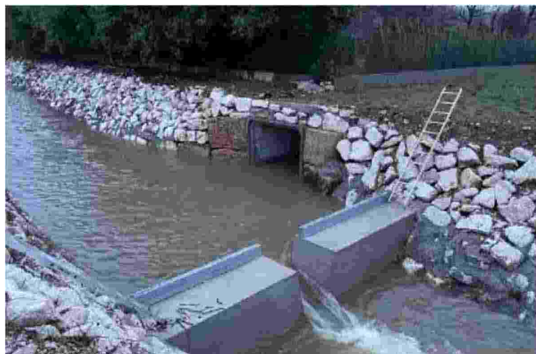
Il canale scolmatore Realizzato nel 2022, garantisce il deflusso delle acque A.D.I.
