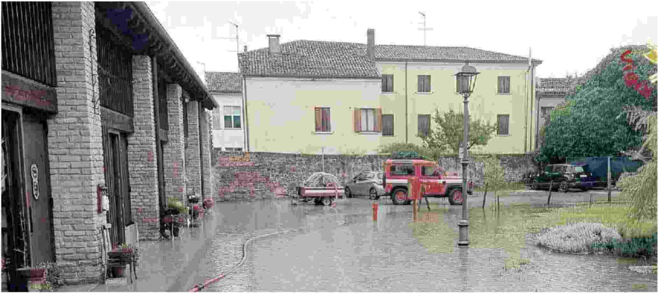
BADIA POLESINE Il problema degli allagamenti da anni mette in crisi la città e i dintorni
