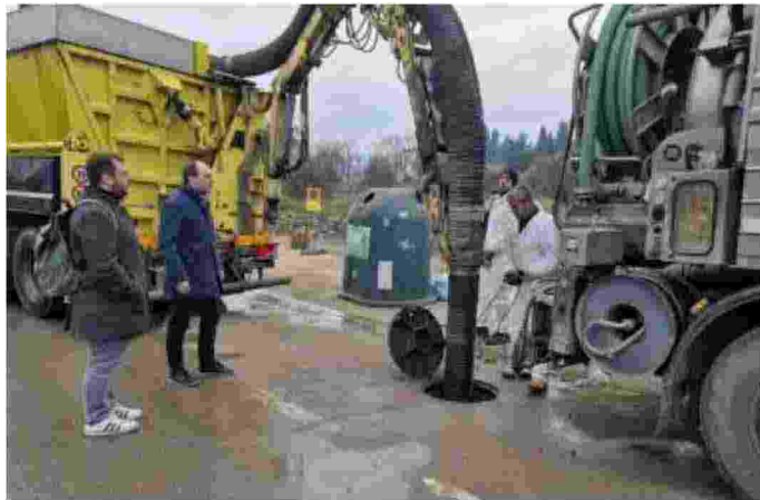
Uno degli interventi di sistemazione del tratto fognario lungo la Montalese
