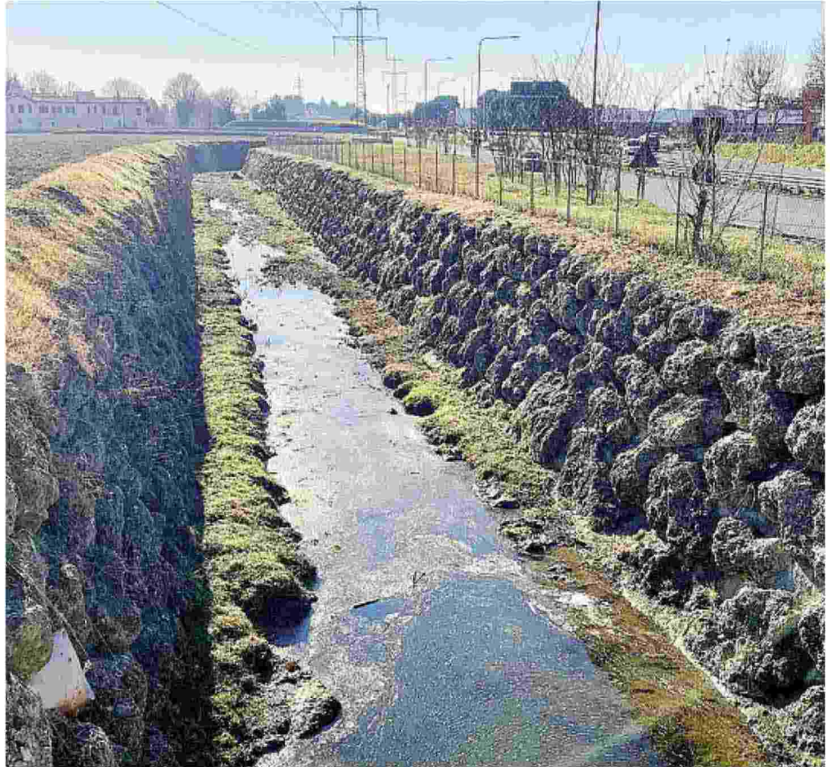
Completata la pulizia di alveo e argini del torrente Riolo
