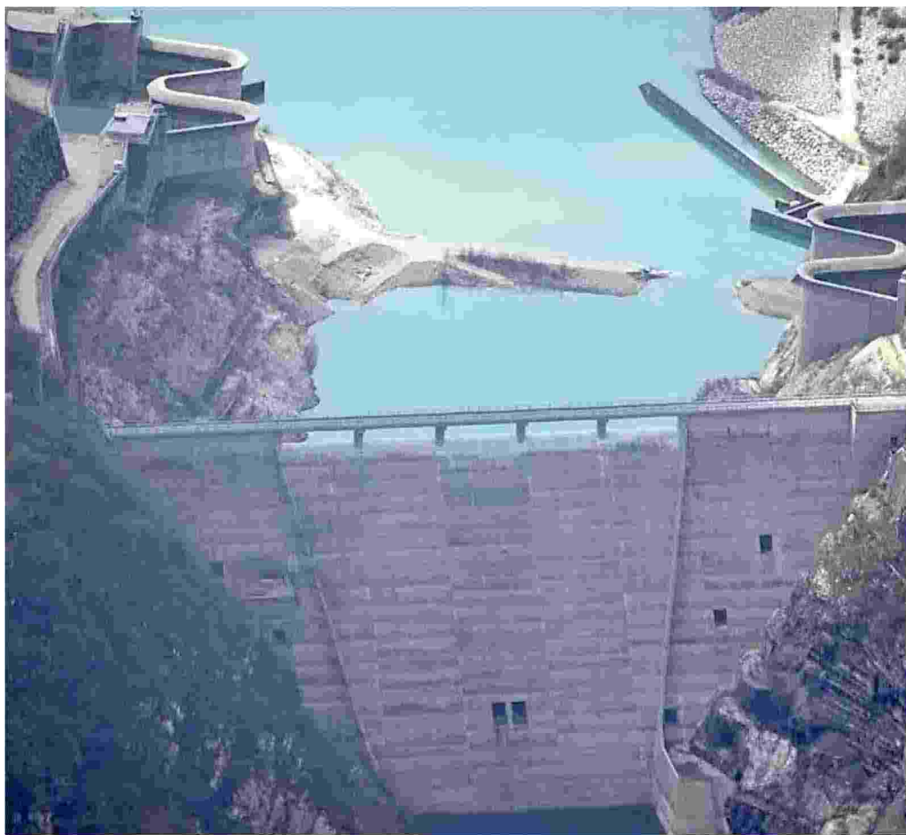
Il 2025 dovrebbe essere l'anno in cui verranno conclusi i lavori della diga di Ravedis FOTO P. VERCESI
