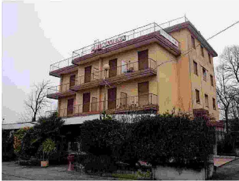
Da abbattere L'hotel Primavera è chiuso da qualche mese. Verrà realizzato un maxi albergo
