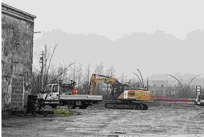
Il cantiere per realizzare la vasca di laminazione ad Albano
