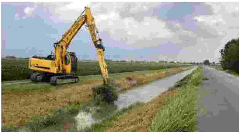
Tra gli interventi: sfalci, espurghi, taglio di piante e riprofilatura dei canali
