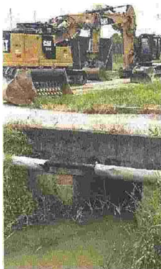
IL CANTIERE Lo scolo Scolauro
