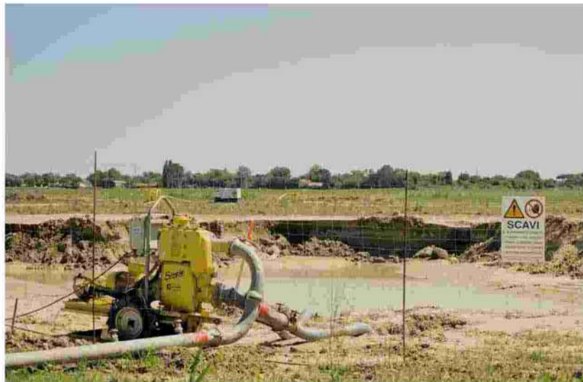
I primi interventi di scavo e sbancamento del terreno FOTO: MASSIMO FIORENTINI
