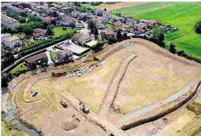
La vasca di laminazione in costruzione a Valtrighe di Mapello
