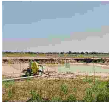
Il cantiere di Snam FOTO FIORENTINI
