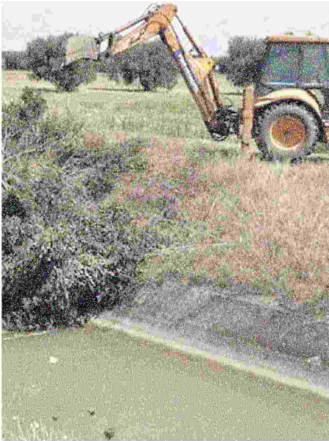
Un intervento degli operai del Consorzio unico su un canale in Puglia per ripulirlo.
