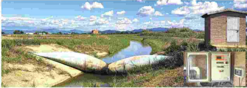
Corso di Bonifica 6 Toscana Sud - Sistema di telecontrollo satellitare impianto dighe mobili per irrigazione grossasetana
