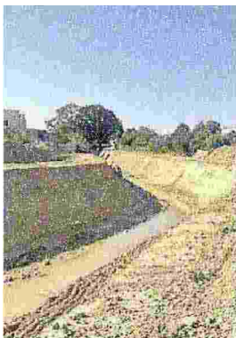
Lavori per fossi
