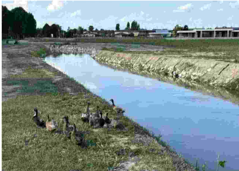
Il canale. A ottobre si svolgerà l'ultima parte dei lavori con la piantumazione e la semina del prato
