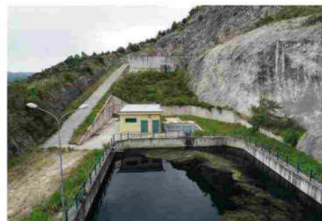
Impianto di Marzanello (CE), opera strategica per l'irrigazione in Campania
