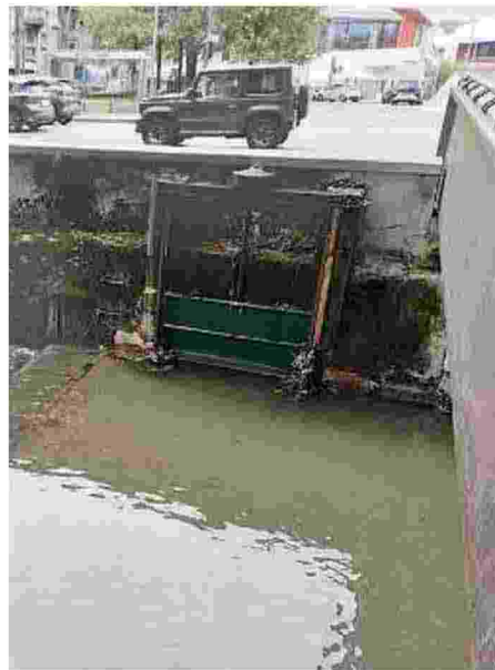
Sostituite. Una vecchia paratoia
