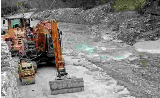
Le operazioni coinvolgeranno numerosi tratti di torrenti e l'alveo dell'Arno
