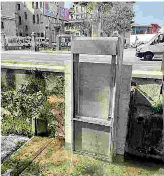
Manufatti idraulici. Quattordici nuove paratoie
