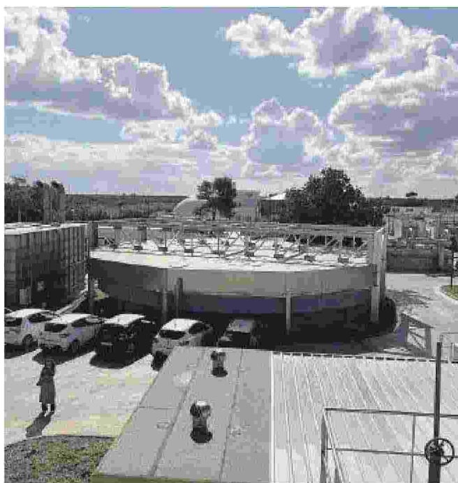
Il nuovo impianto di depurazione delle acque reflue
