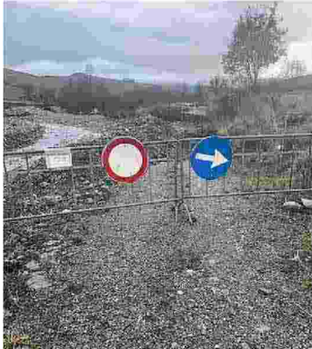
Lavori L'intervento sugli argini del torrente Formone
