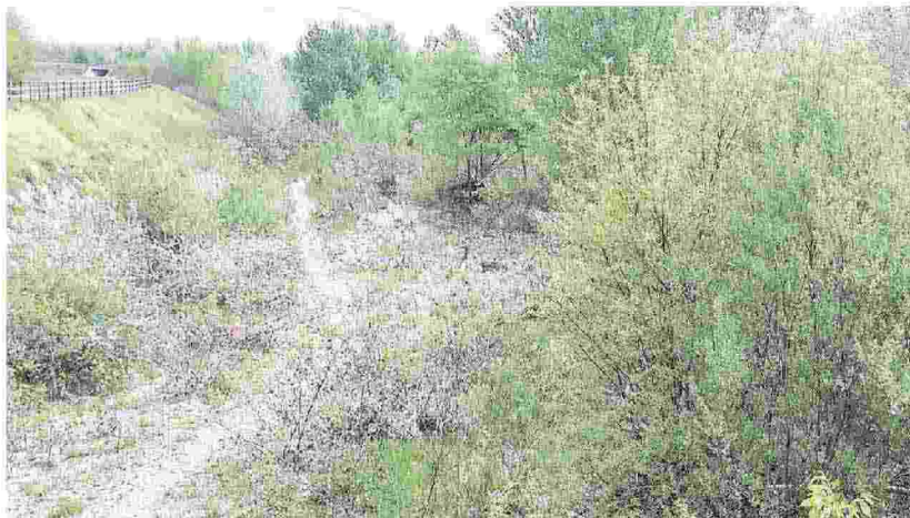
L'alveo del torrente Versa è invaso da arbusti e alberi
