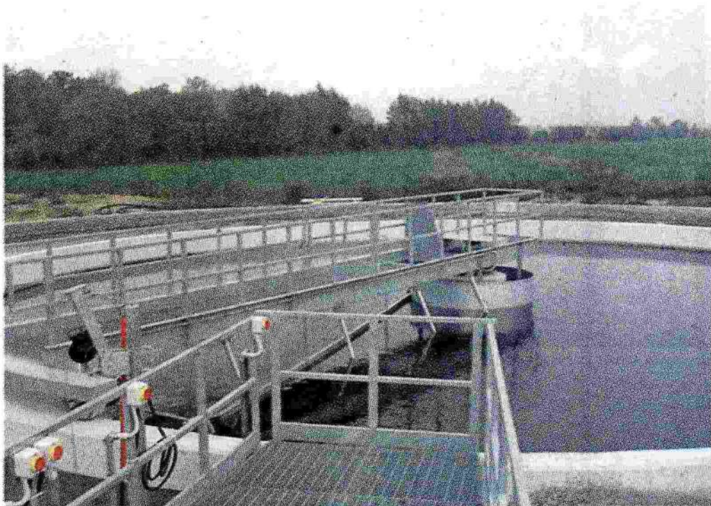
Il depuratore di Tavernola
