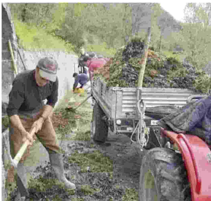
OPERE ATTESE Operai al lavoro vicino al letto di un torrente
