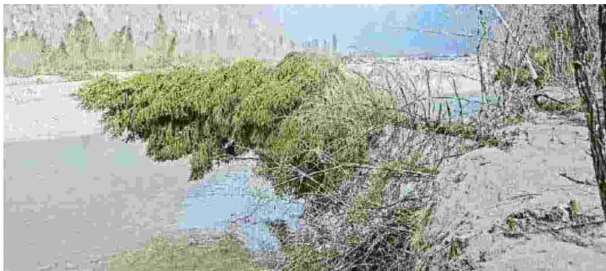
Molti cantieri che saranno aperti lungo il Cordevole, alcuni sono già in opera
