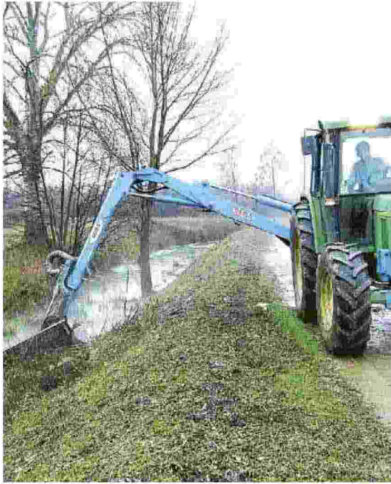
Lavori del consorzio di bonifica lungo un fosso
