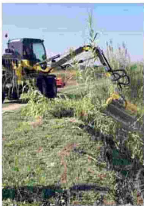
Una ruspa al lavoro in un canale del Consorzio a Oristano
