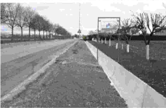
Uno dei vasi rimessi a nuovo dopo i danni provocati dal maltempo
