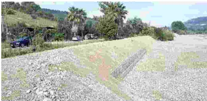
no di due mesi ha completato l'attività, ricostruendo gli argini con massi ciclopici e gabionate di materiale inerte. Non è stato un lavoro semplice e per vari aspetti. Il più ostico ha riguardato il superamento della situazione logistica. In un primo momento al Co-
