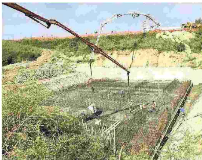
I lavori per la realizzazione della controchiavica
