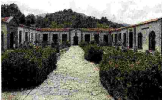
Sicurezza Il cimitero di Tornolo dove sono stati fatti i lavori.
