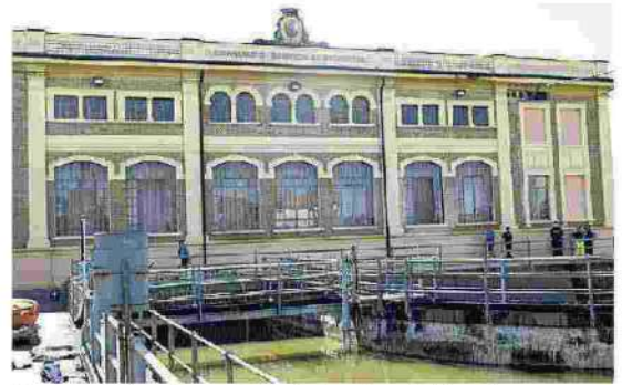
L'impianto del Torrione, a Gualtieri, che oggi ospita l'incontro
