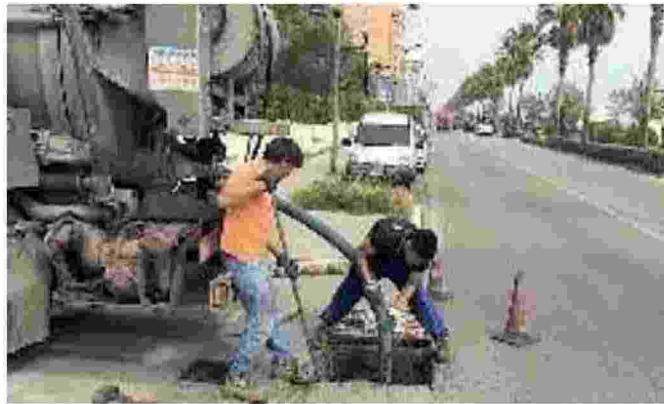
Operai al lavoro ieri in via Bocca di Valle
