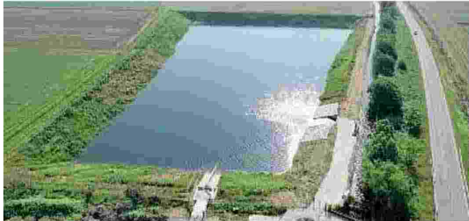
Vasca di laminazione. L'opera realizzata a Castrezzato
