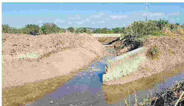
Ambiente. Il canale circondariale che dovrà essere sistemato
