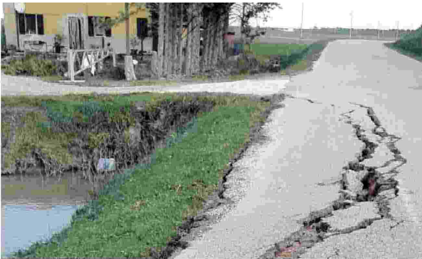
BOCCASETTE La strada parzialmente franata a causa delle piogge, uno dei tanti danni dopo il nubifragio e il vento di lunedì
