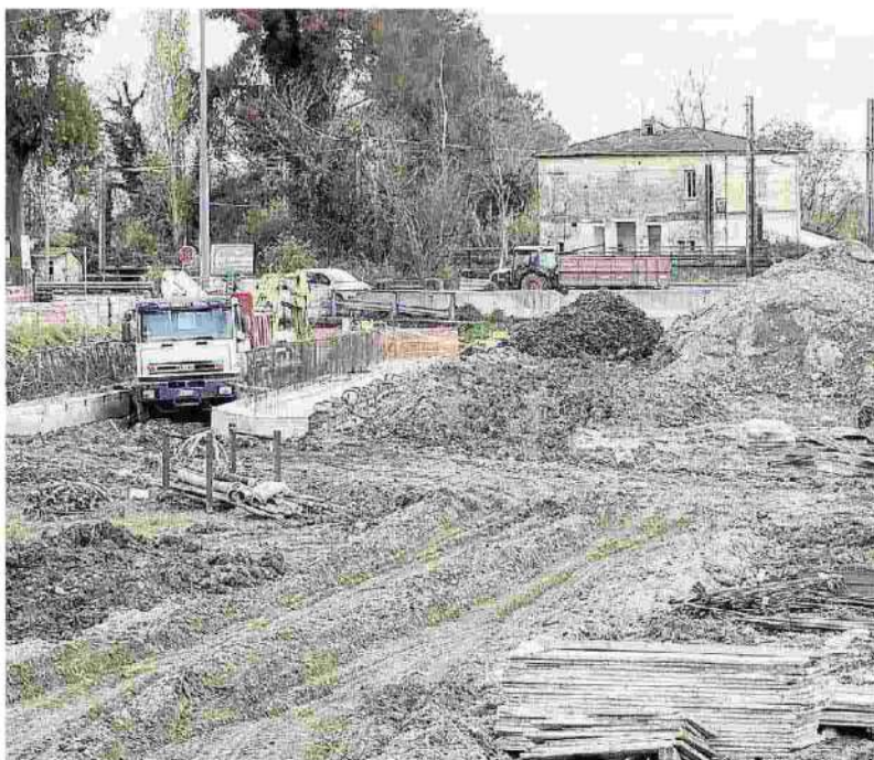
L'area di cantiere per la nuova rotondella all'uscita dell'autostrada
