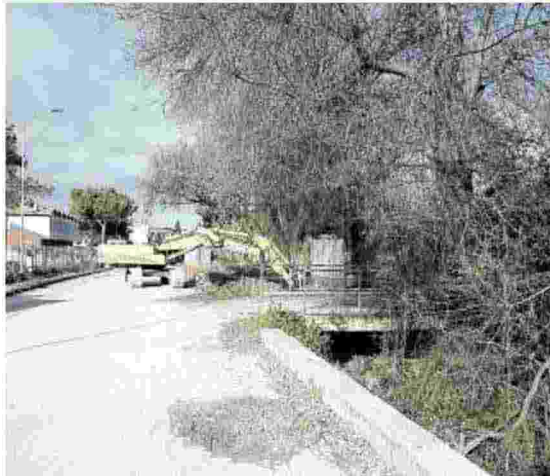
I lavori per la messa in sicurezza dei fossi
