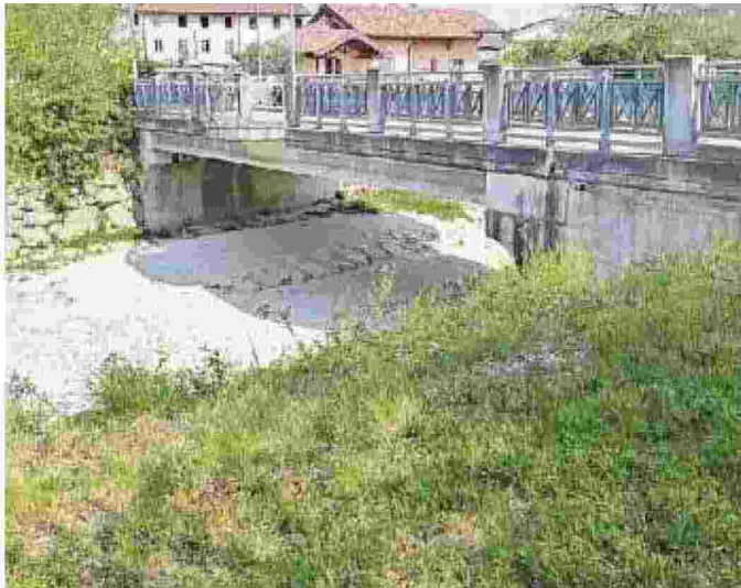
Il ponte di via Zugliano a Basaldella che dovrà essere rifatto
