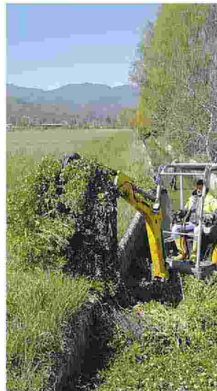
Le operazioni di sistemazione dei canali situati lungo la piana reatina.
