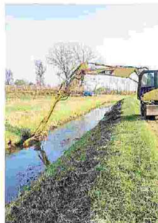
Pulizia di un canale
