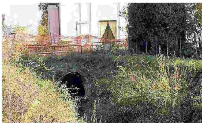
Il tratto di canale oggetto dei lavori di ripristino
