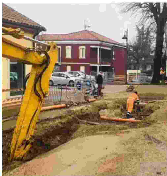
Un'altra foto dei lavori per la sistemazione della condotta. BILLO
