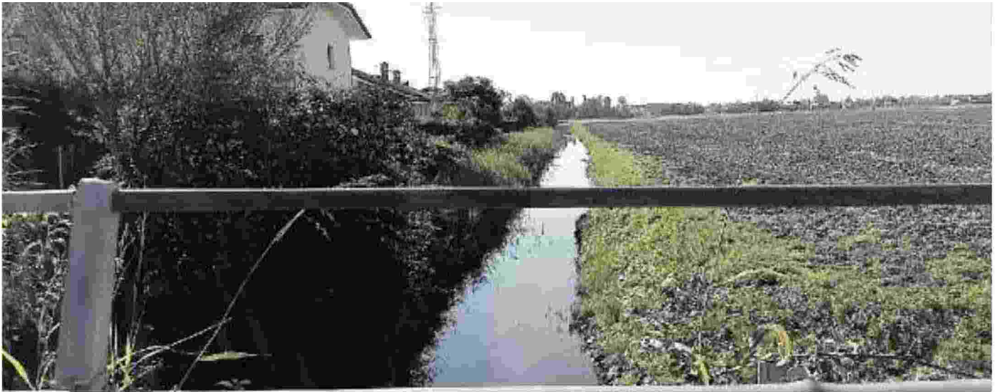
PORTO VIRO Lo Scolo Cavana sul quale si affacciano le abitazioni di Borgo Mimose: impossibile effettuare la manutenzione
