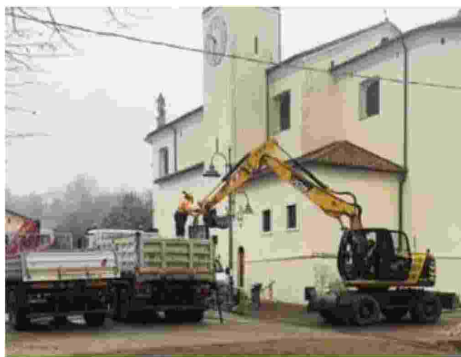
I lavori sulla vecchia tubatura a Montecchio Precalcino. FOTO BILLO
