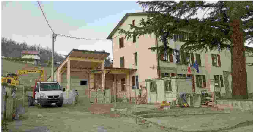
VALMOZZOLA Lavori in corso per la realizzazione della caldaia a cippato.
