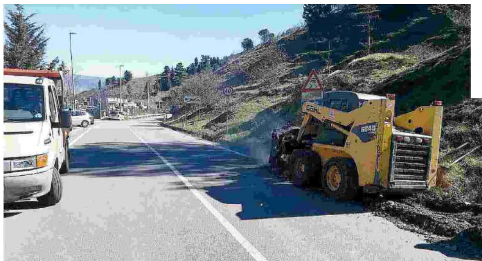
Lavori idrici. Ruspe in azione per rifornire di acqua due contrade
