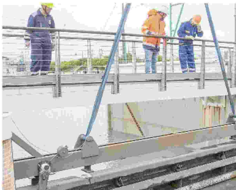
CONSORZIO BONIFICA I tecnici al lavoro al Ponte del Gatto in corrispondenza del passaggio a livello
