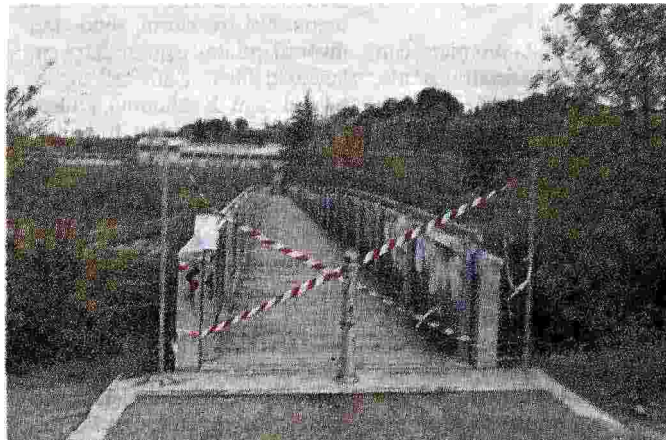
Transenne Sono iniziati i lavori sull'argine del torrente Termina.
