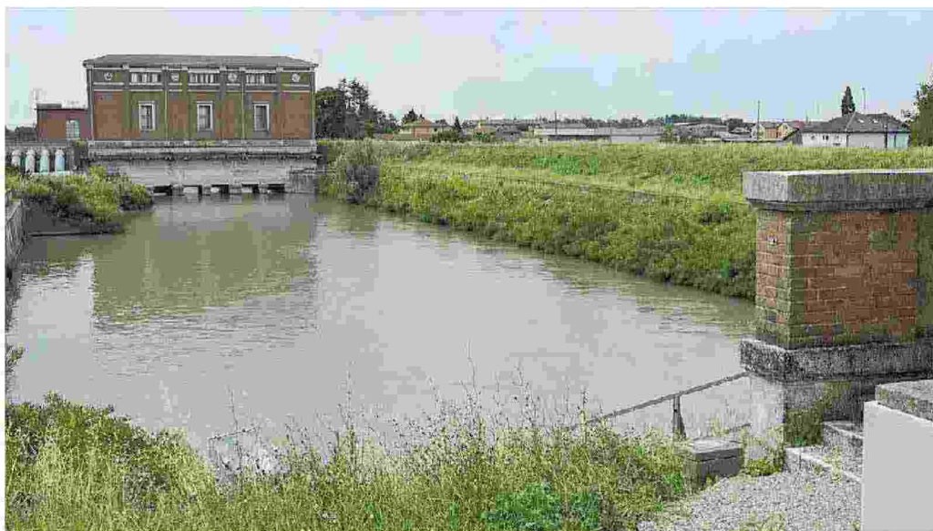
L'impianto della bonifica a Boretto
