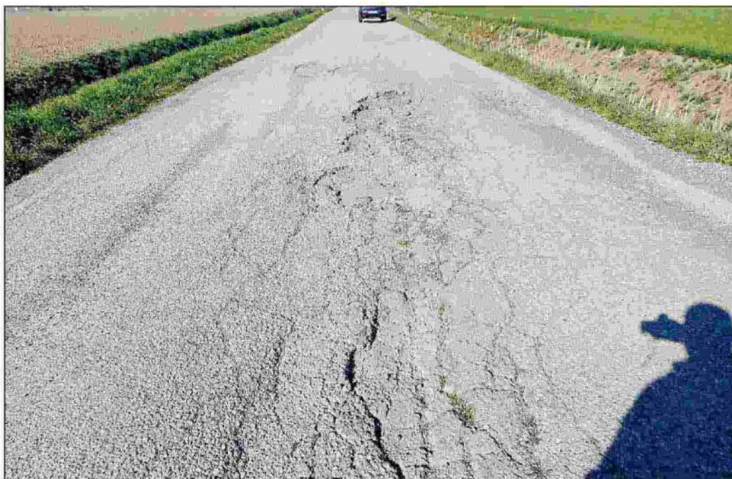
Le condizioni dell'asfalto in via Cavo Bentivoglio, tra Censelli e Castelnuovo Bariano
