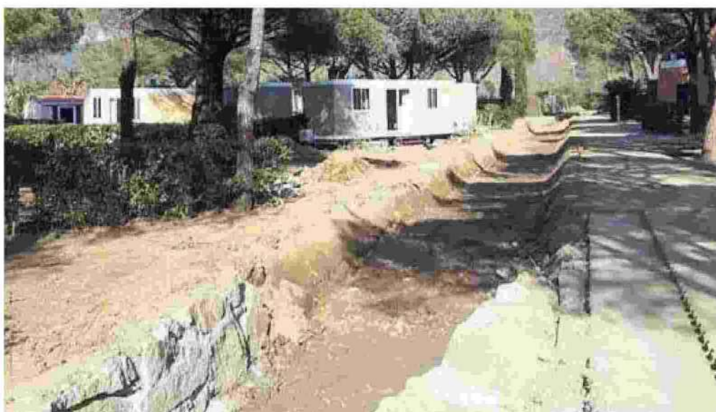
Lavori lungo il fosso di Segagnana
