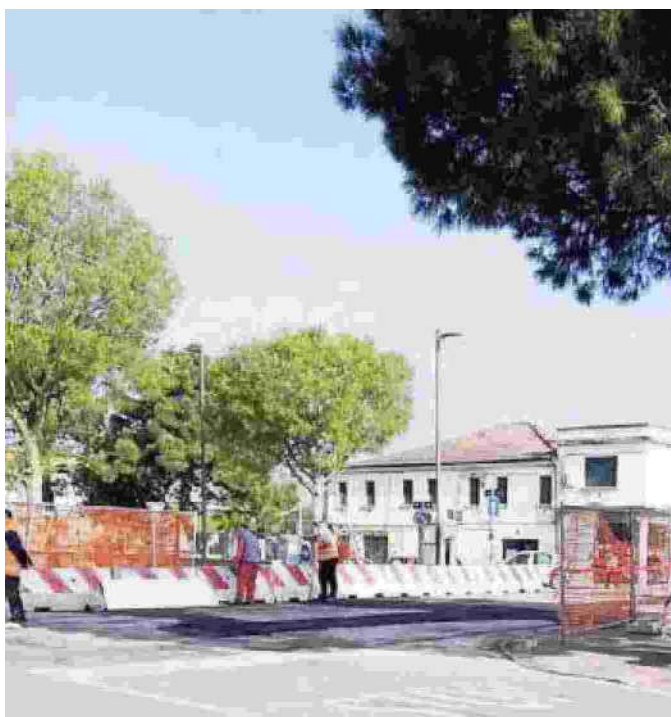
Il cantiere sul ponte del canale Ippolito a Pontelangorino
