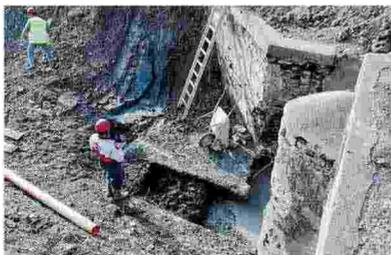
L'acqua aveva eroso anche parte della soletta. Il tutto è stato rimesso a nuovo senza chiudere la strada
