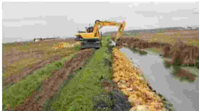
Operai al lavoro sugli argini dello scolo San Marco
