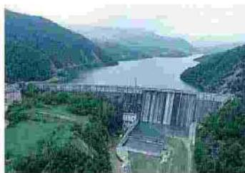
● Sarà recuperato nuovo spazio utile all'interno della diga di Mignano, in comune di Vernasca, per poter stoccare più acqua nella calda stagione estiva. Come? Rimuovendo gran parte del materiale ghiaioso e limoso depositato nel tempo sul fondo dell'invaso, per un volume pari a 300 mila metri cubi.
