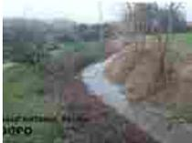
Per quanto riguarda il fosso Sant'Antonio, gli operai hanno trinciato rovi e canne per poi passare alla risagomatura dell'alveo attraverso la **rimozione di materiale limoso e roccioso** che si era accumulato in punti isolati del letto, impedendo il naturale passaggio delle acque. Il materiale che era stato asportato è stato poi **utilizzato per rinforzare gli argini**.
