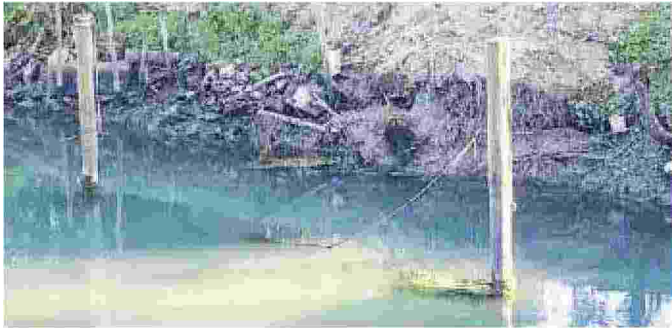
Il tratto del fiume Terzo per il quale sono necessari interventi
