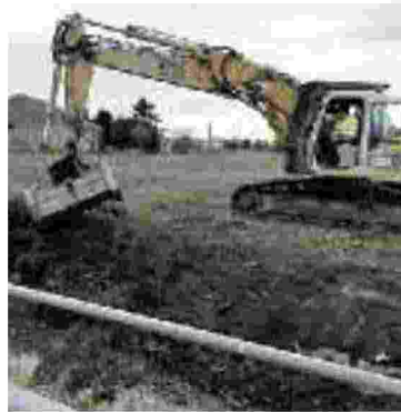
CANTIERI Presto i lavori per scongiurare gli allagamenti
