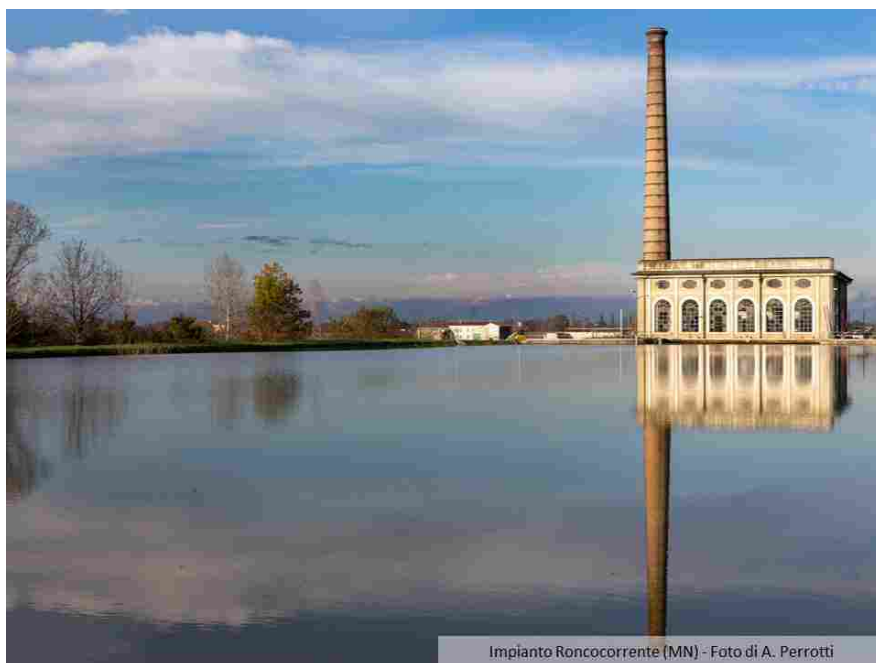
Impianto Roncocrete (MN) - Foto di A. Perrotti
