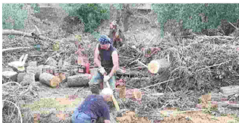
DETRITI Gli operai del Consorzio sui luoghi alluvionati di Livorno
