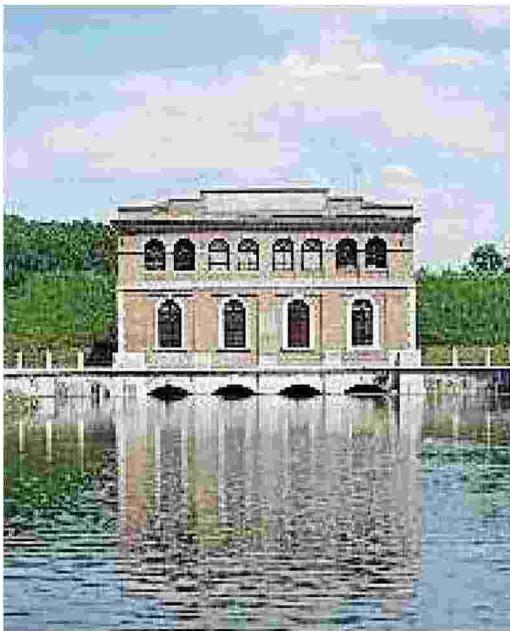
Botte Villoresi, una delle strutture più importanti del Consorzio di Bonifica
