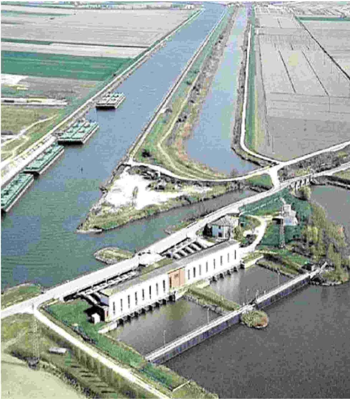
SALVAGUARDIA IDRAULICA L'idrovora di Cavanella Po, una delle tante costantemente attive in Polesine per garantire la difesa del suolo che si trova sotto il livello del medio mare a causa della subsidenza creatasi con le estrazioni di idrocarburi negli anni 50-60.
