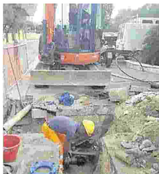
Lavori in corso sulla rete idrica
