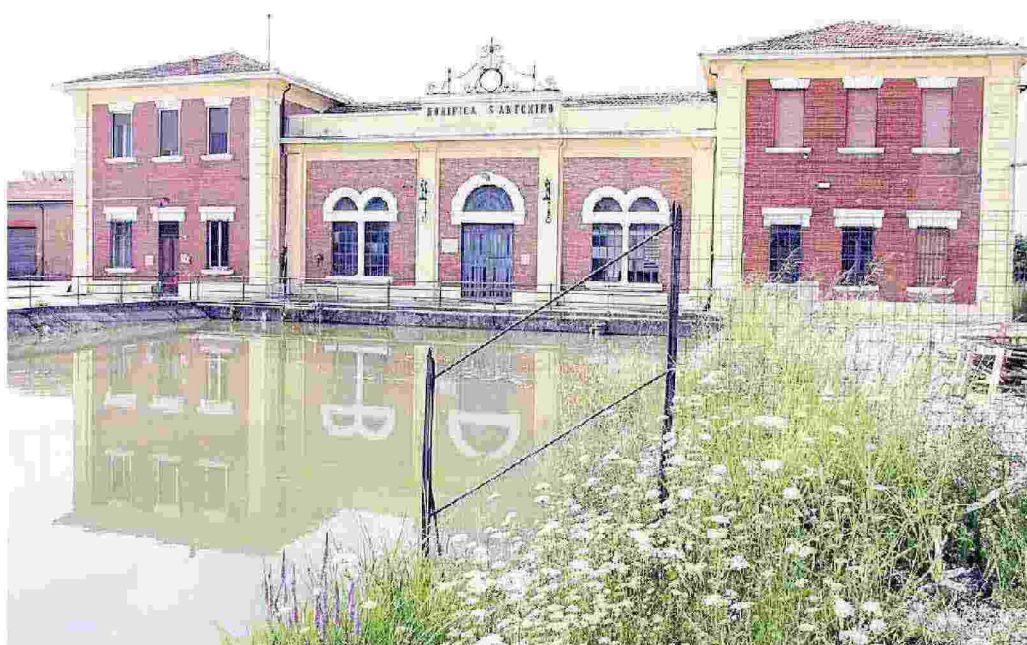
Impianti idrovori del Consorzio di Bonifica
