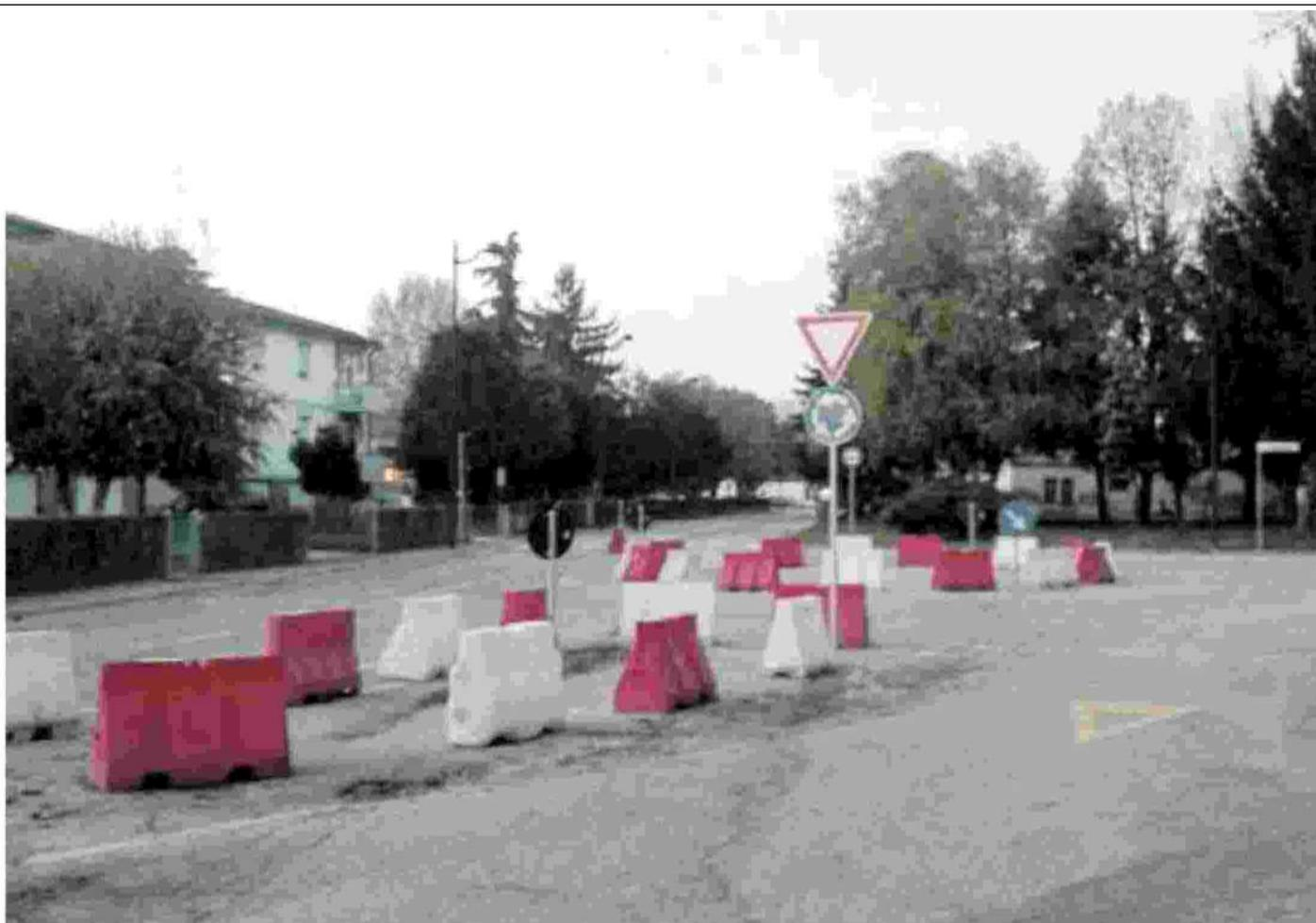
PROVE I new jersey che sono stati posit per sperimentare la soluzione della rotatoria di fronte all'ex Enel
