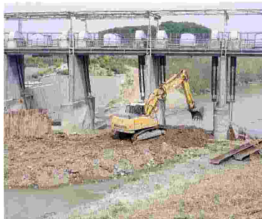
Ruspe al lavoro sulla diga crollata
