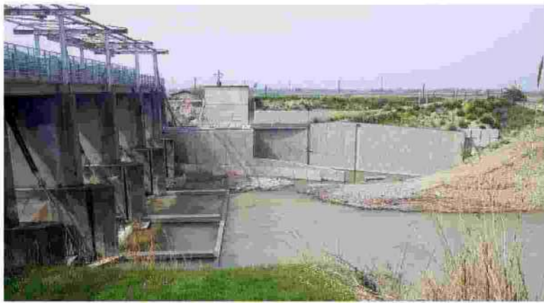
I lavori in corso alla chiusa San Bartolo, per il ripristino del manufatto, degli argini, della strada e delle opere idrauliche dopo il crollo dell'ottobre scorso. FOTO MASSIMO FIORENTINI
