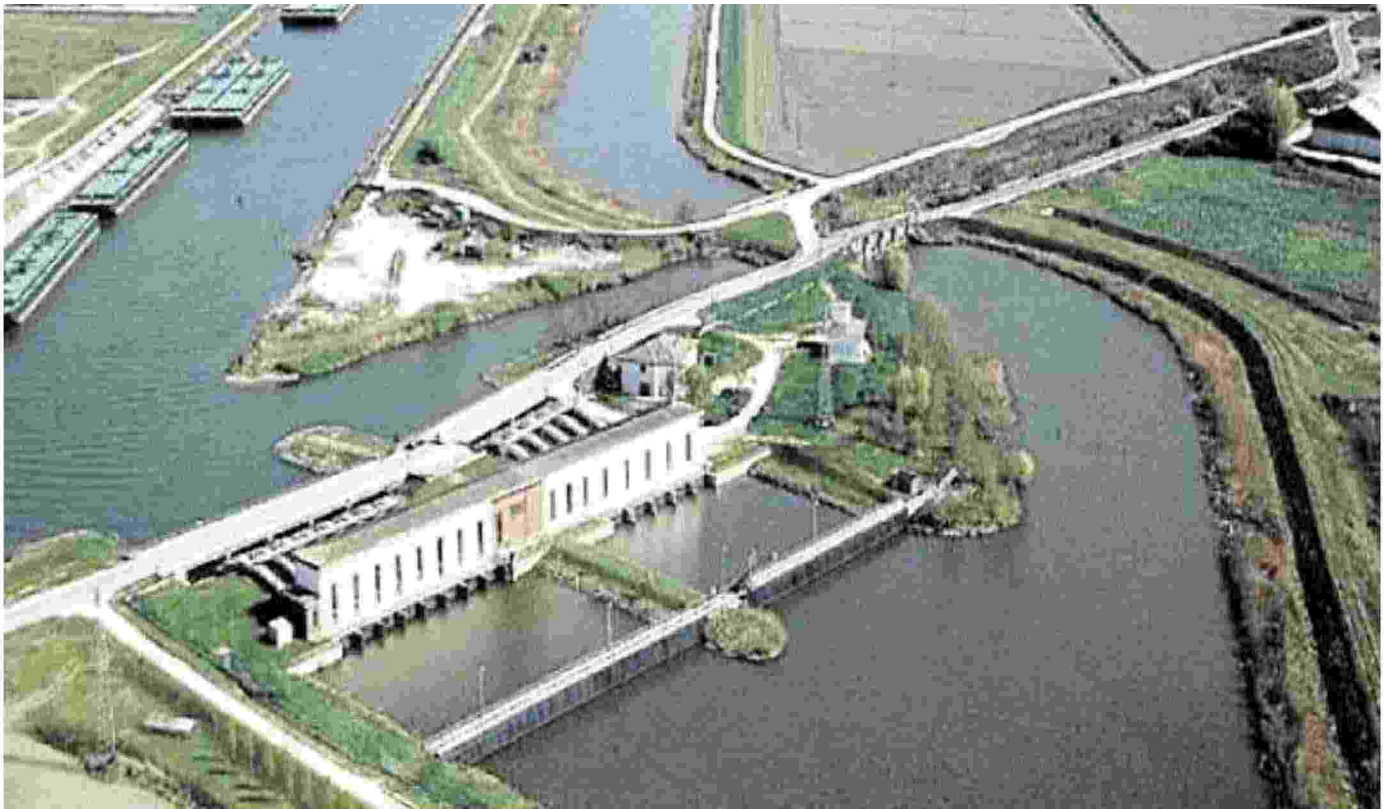
OPERE IDRAULICHE E SUBSIDENZA L'impianto idrovoro di Cavanello Po, uno dei maggiori dell'intero Polesine alle porte del Delta
