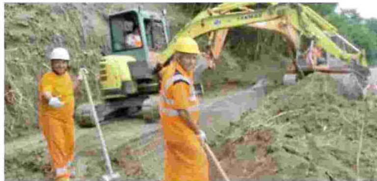
Operai a lavoro in un cantiere (foto di repertorio)
