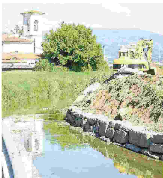
Cantiere del Consorzio Ombrone in comune di Quarrata
