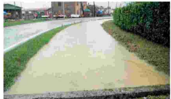
Il cantiere allestito in via Mesolino e una piena invernale con rischio esondazione
